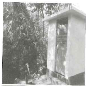
校舎の横に建てられたトイレ
